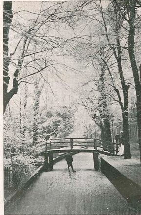
Eigen opname. Zaandijk, Hoofdweg.
